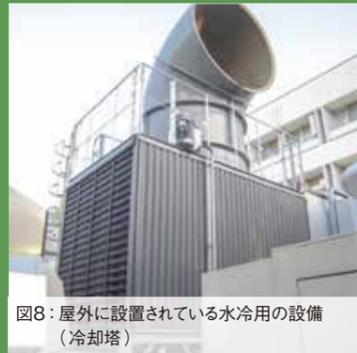
図8: 屋外に設置されている水冷却用の設備 (冷却塔)
