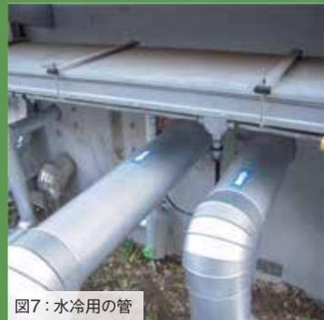
図7: 水冷却用の管
